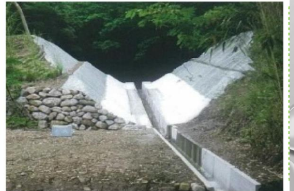
廃止工事（掘割）
