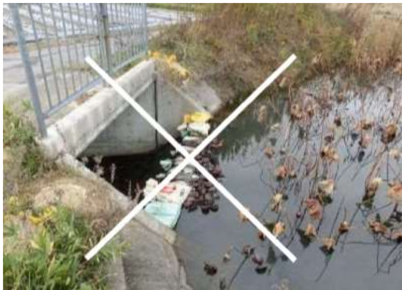
土のうによるかさ上げ
