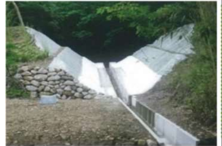
廃止工事(開削)
