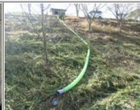
ため池下流側
