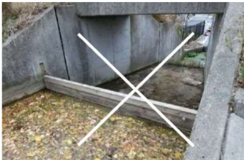
堰板によるかさ上げ
