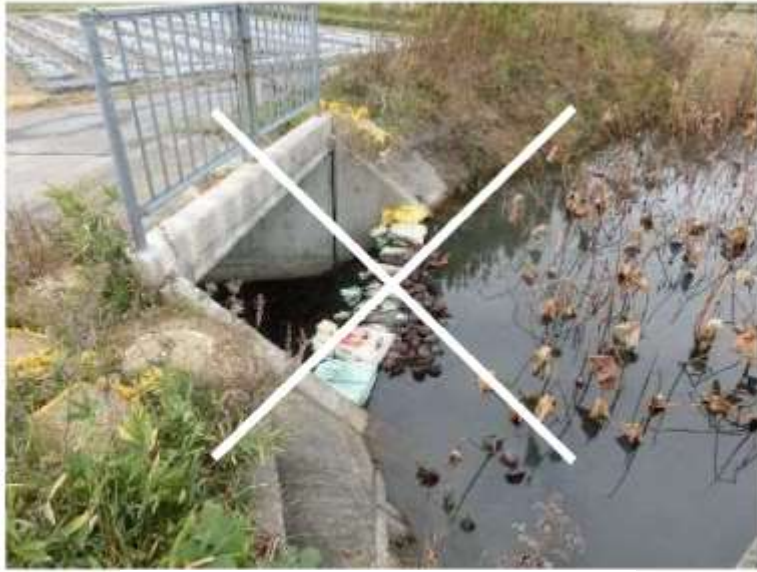
土のうによるかさ上げ
