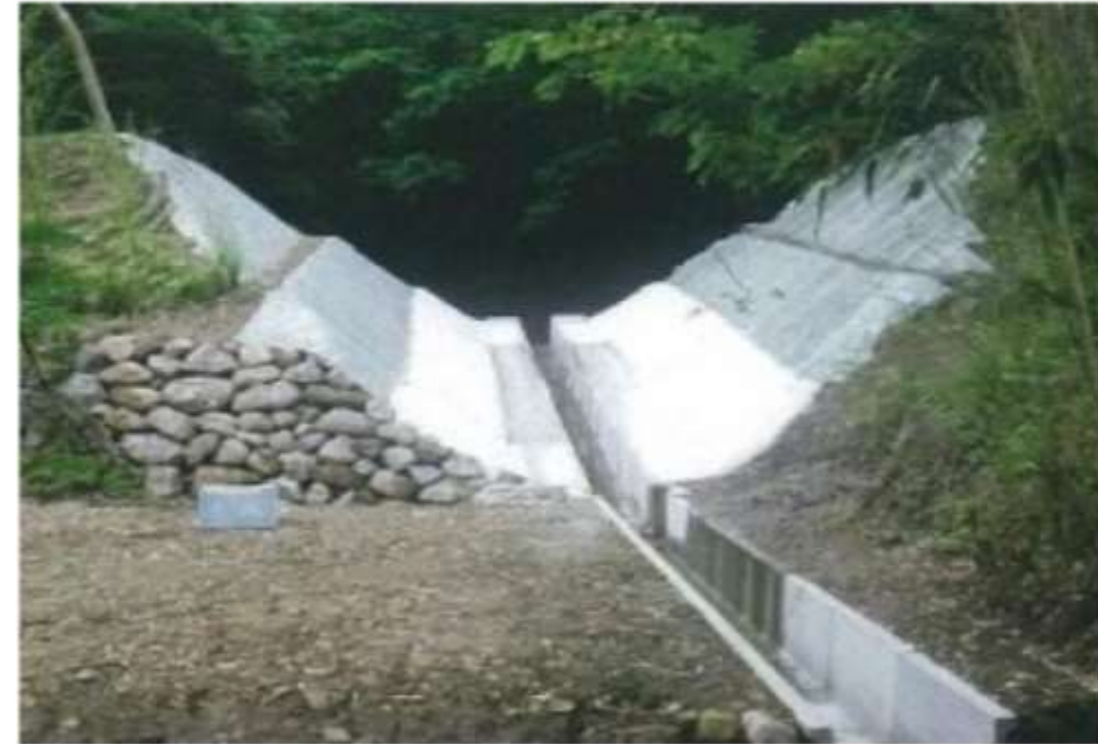
廃止工事(開削)
