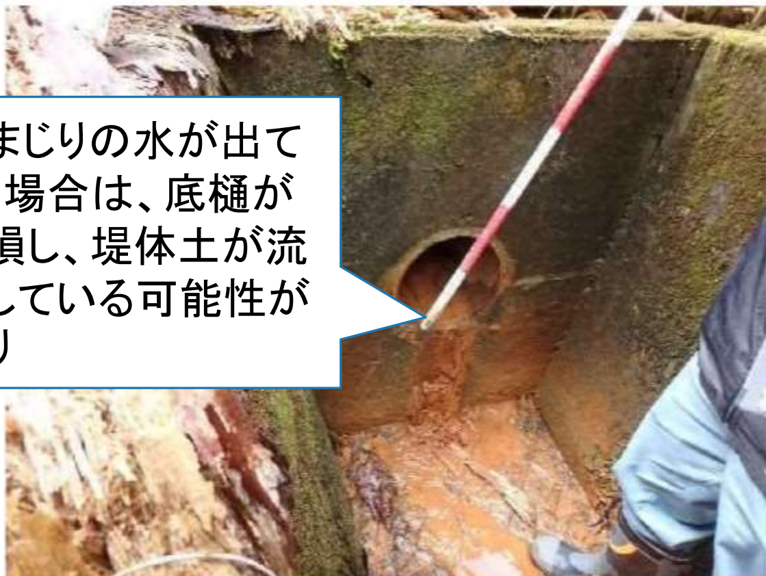
底樋出口(堤体下流)
