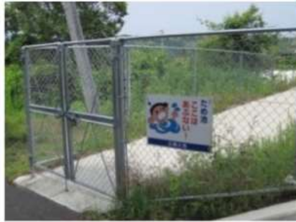
進入防止フェンスの設置
