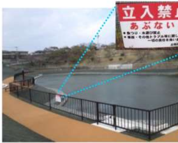
転落防護柵と警告看板の設置
