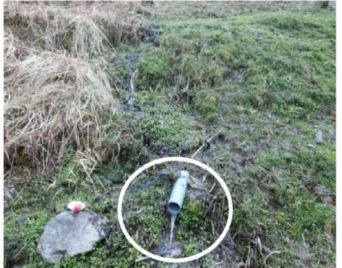
外法 漏水(遠景)
