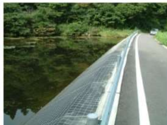
安全ネットの設置
