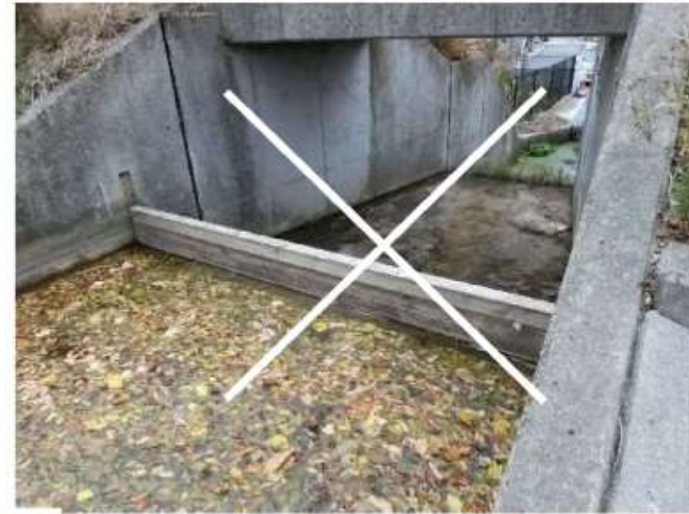
堰板によるかさ上げ
