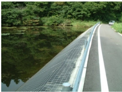
安全ネットの設置
