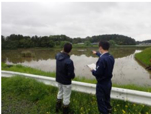
ため池の点検
